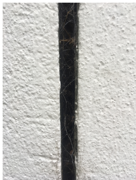
Junta de dilatación sin material elástico | Fuente: Fotografía propia
