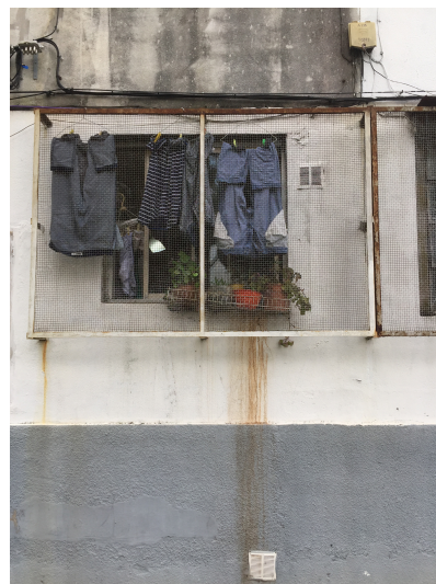
Oxidación rejilla metálica | Fuente: Fotografía propia
