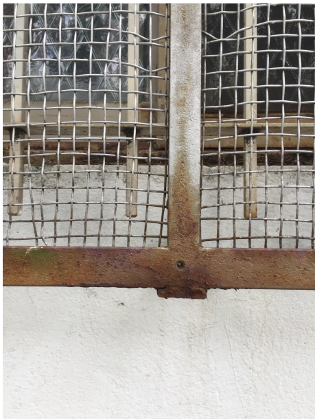
Oxidación de la reja metálica | Fuente: Fotografía propia
