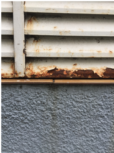
Corrosión postigo metálico | Fuente: Fotografía propia
